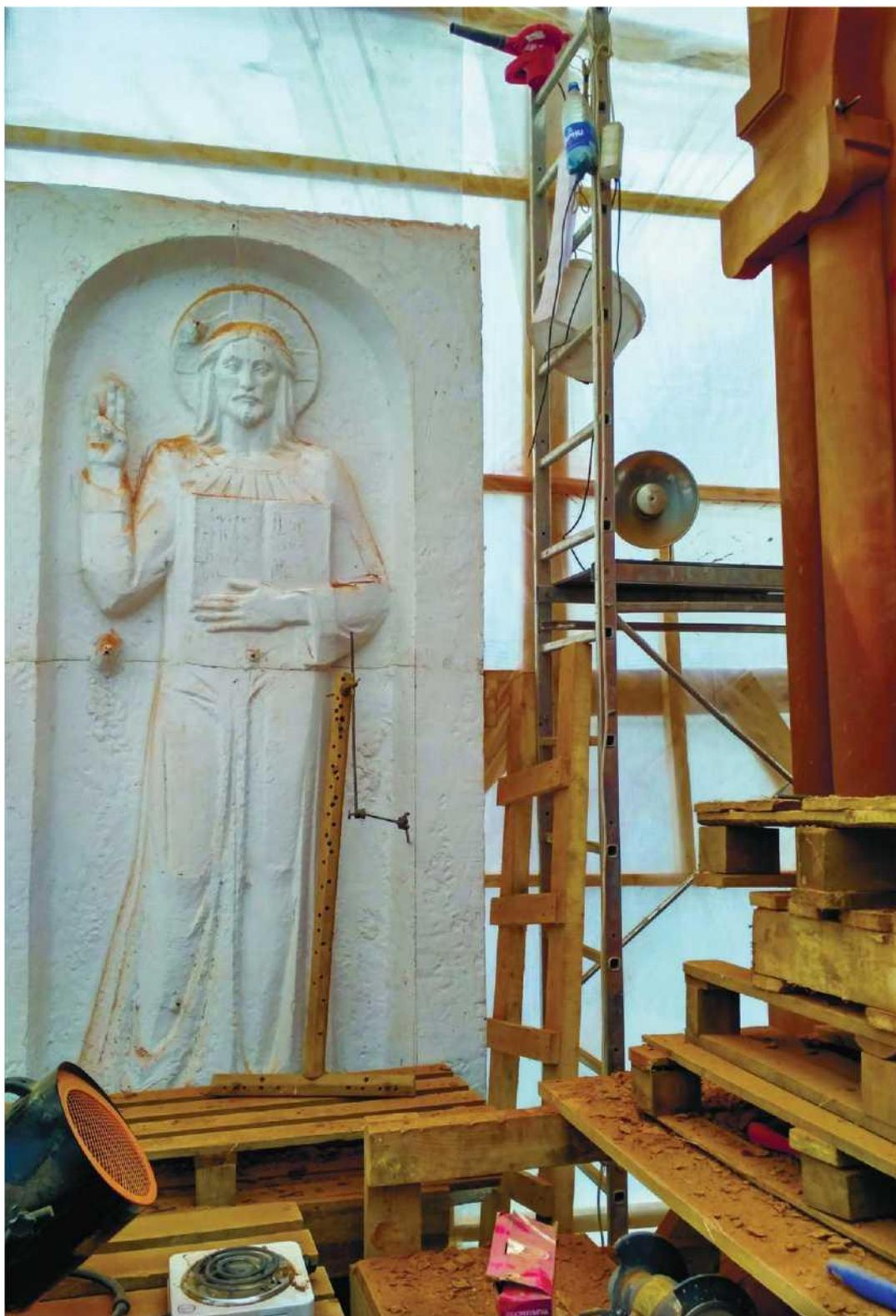
Рис. 40. Перевод с гипсовой модели на туф на месте внутри строительной конструкции, в которой поддерживаются оптимальная влажность и температура для работы скульптора
