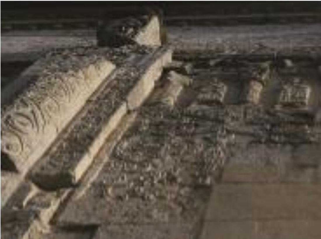
Рис. 4. Соединение разнородных элементов фасада храма
