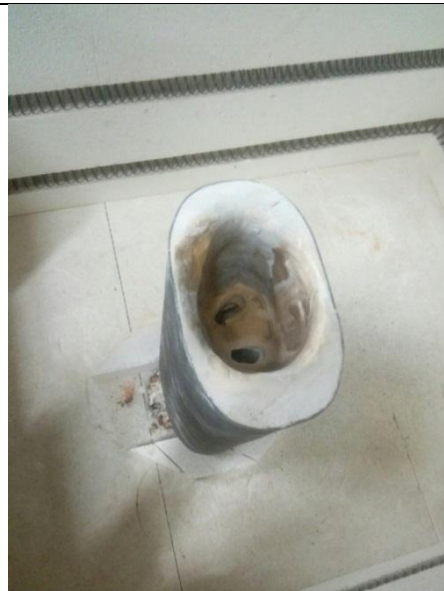
16. Прожженная опока, установленная в печь
